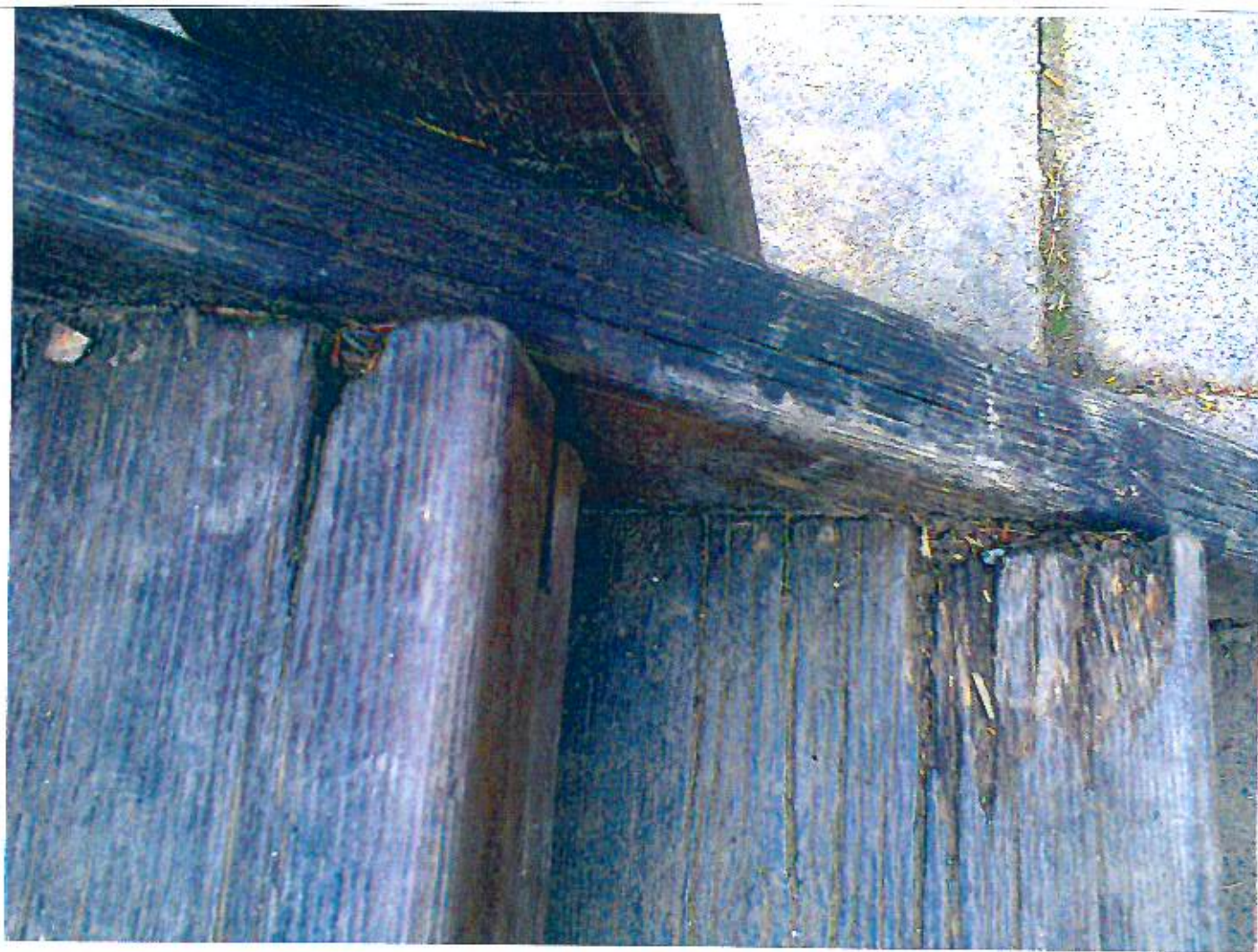
SCUOLA MATERNA APRIERO FOTO 3 GIOCO COMBINATO SOSTITUZIONE GRADINI SCALETTA
