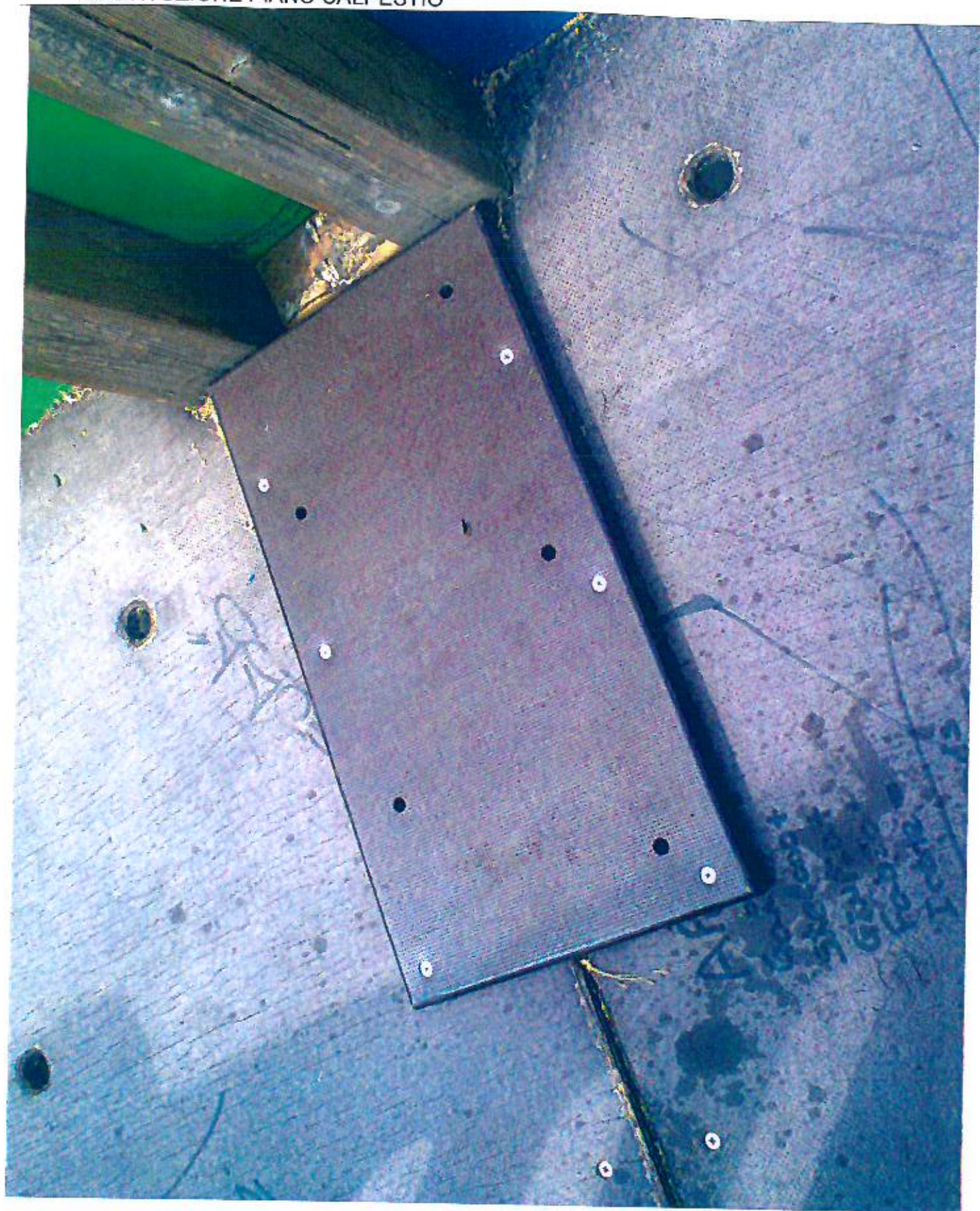
GIARDINO DELLA MEMORIA FOTO 1 GIOCO PALESTRA ARRAMPICATA SOSTITUZIONE PIANO CALPESTIO
