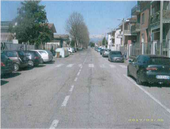
Segnaletica stradale orizzontale esistente
