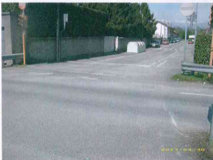
Vista di insieme della via Rivalta dalla SP 6
