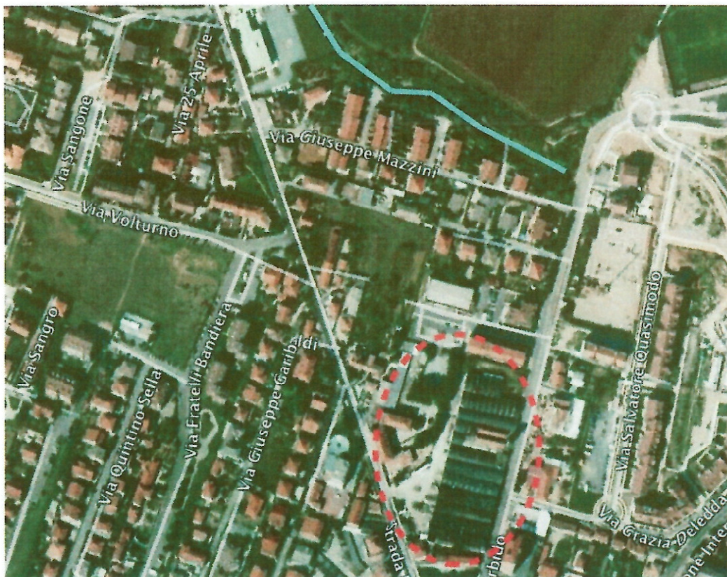
Illustrazione 20: foto aerea del sito con ubicazione approssimativa del sito (Google Maps), si noti la distanza tra il tratto a pelo libero del Canale di Orbassano e gli edifici esistenti sull'area di progetto.
