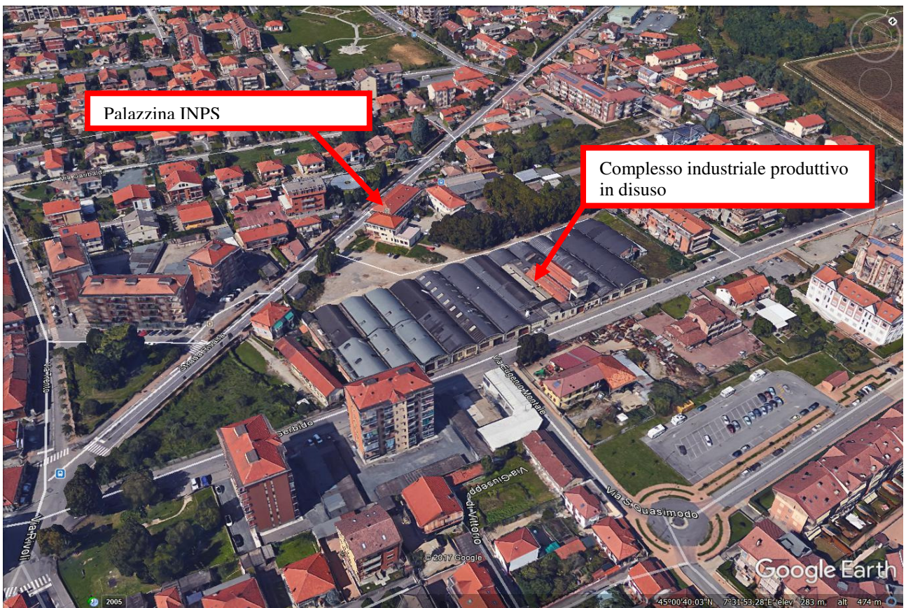
Foto 7: Foto area (Vista angolo Nord)
