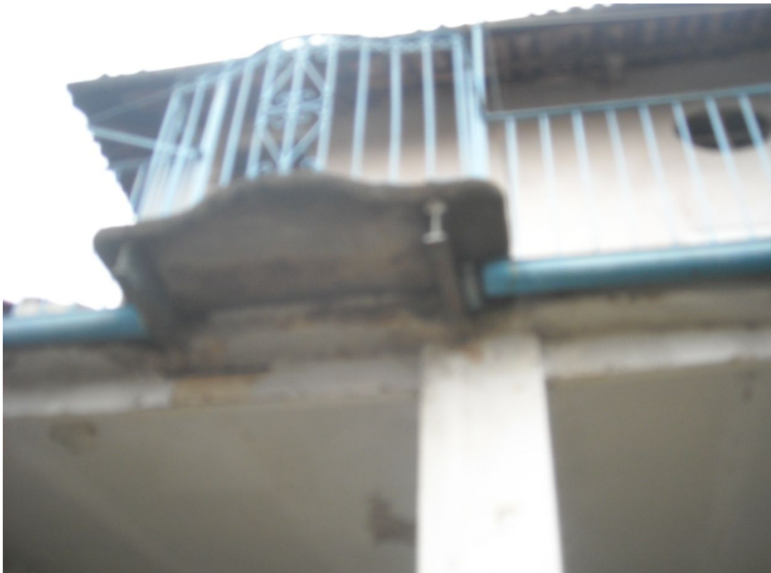
Particolare balconcino fabbricato A
