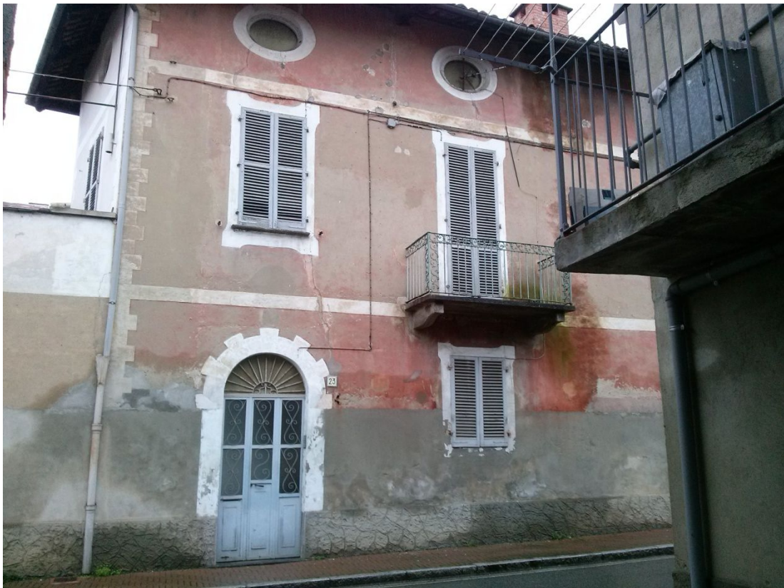
Vista da via Nino Bixio fabbricato A
