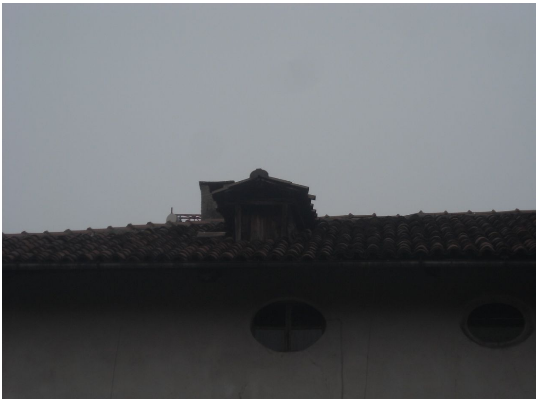
Particolare occhio di gatto ed abbaino fabbricato A
