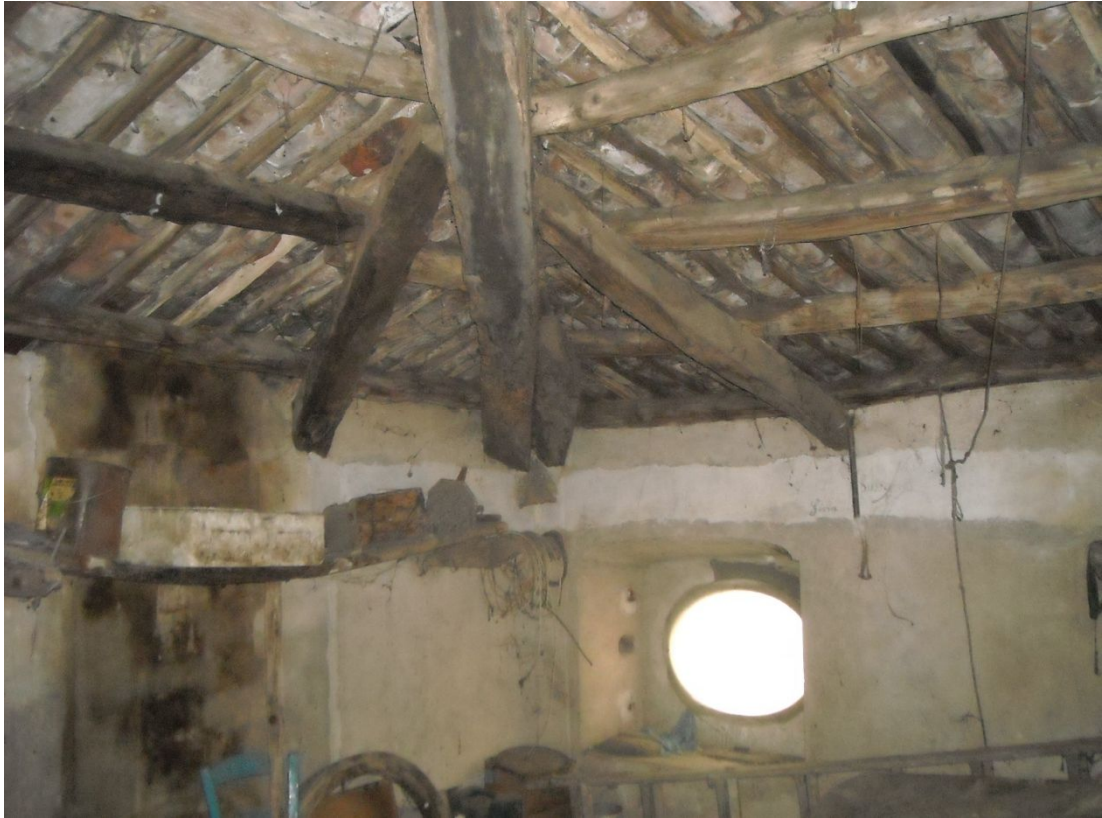
Particolare del tetto e muratura fabbricato A
