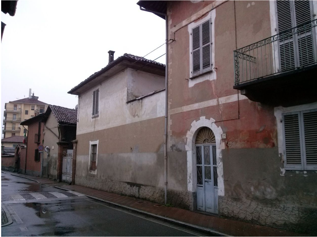
Vista su via Cavour verso sud
