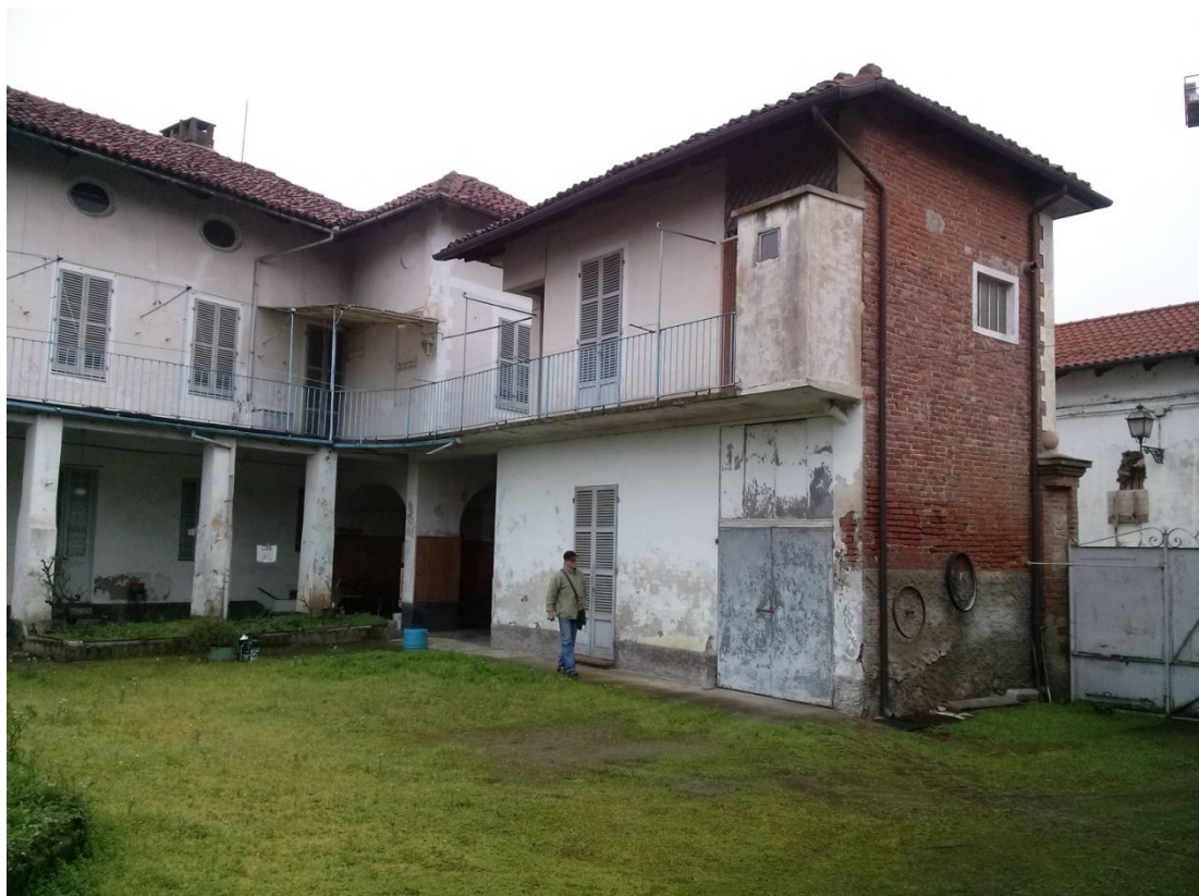
Vista da interno cortile verso via Cavour fabbricato B
