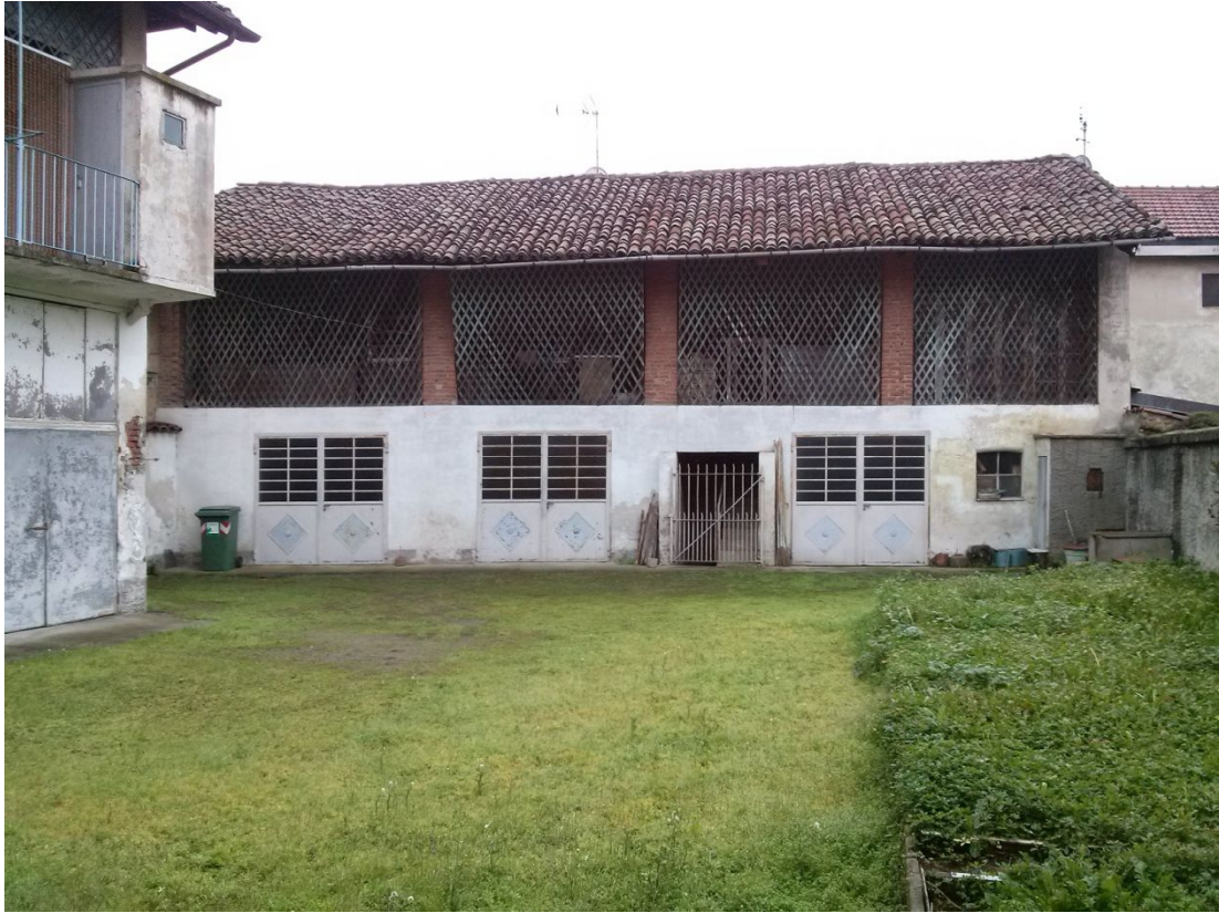
Vista da interno cortile verso sud fabbricato C
