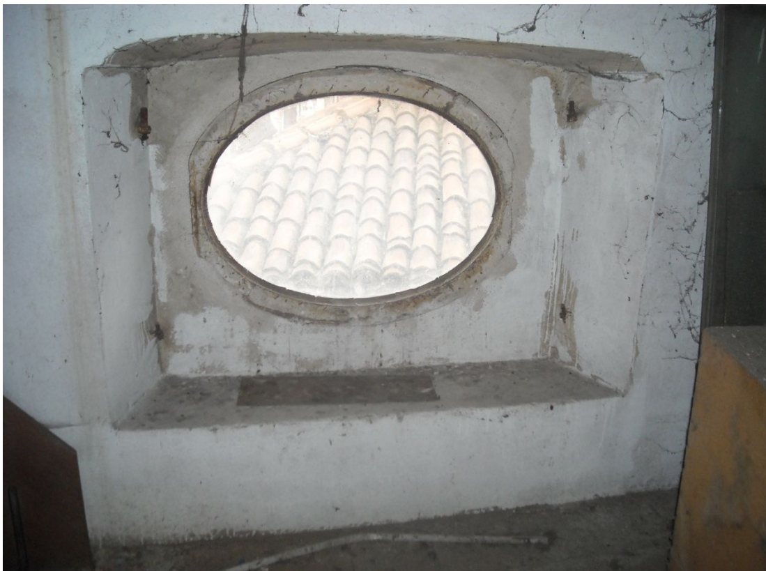
Particolare occhio di gatto visto dall'interno fabbricato A
