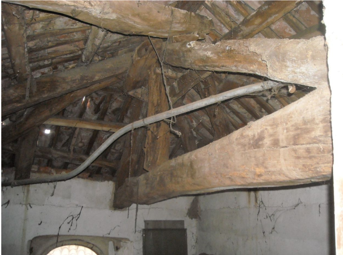
Particolare del tetto fabbricato A
