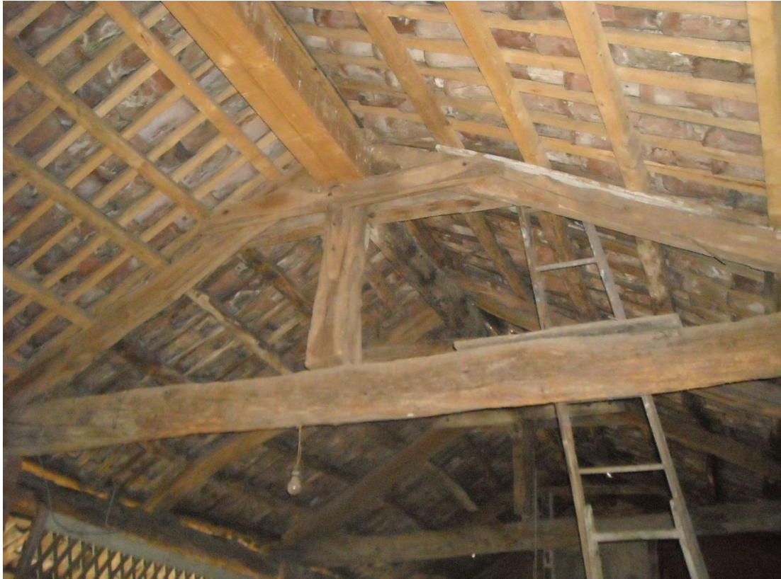
Particolare del tetto fabbricato c
