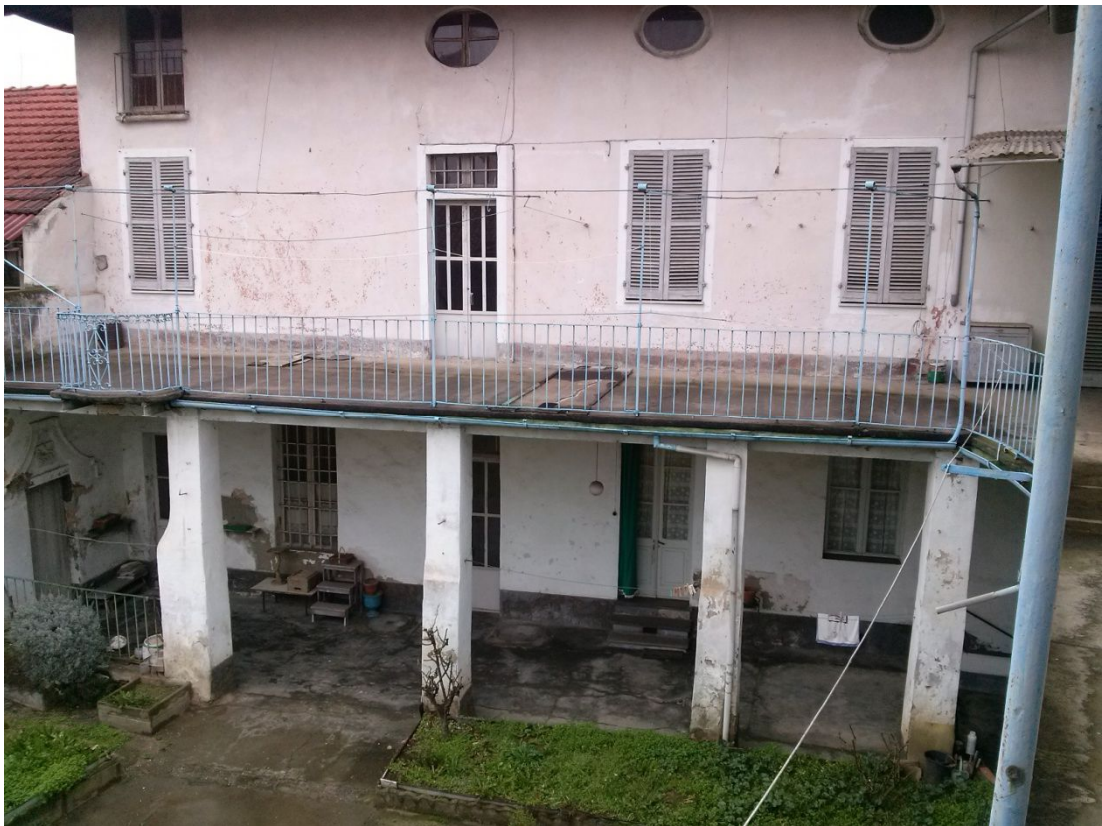
Vista da interno cortile fabbricato A
