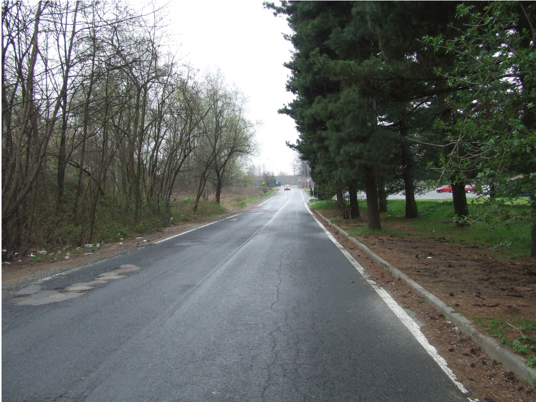
Tratto di SP 174 compreso tra ingresso ospedale e parcheggi
