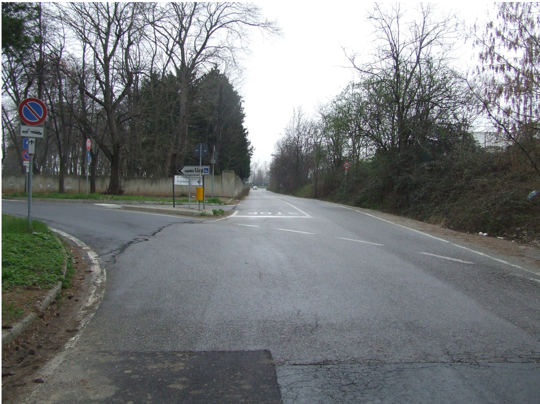
Incrocio Strada Regione Gonzole SP 174 – Ingresso ospedale
