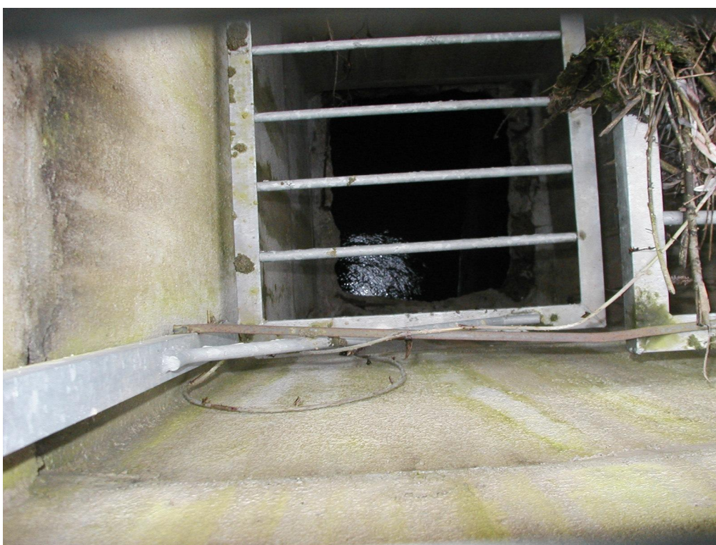
Figura 2-22 – Accesso al collettore principale del SITO ubicato oltre la strada di fronte al parcheggio basso dell'Ospedale San Luigi (foto 247-P1020066)
