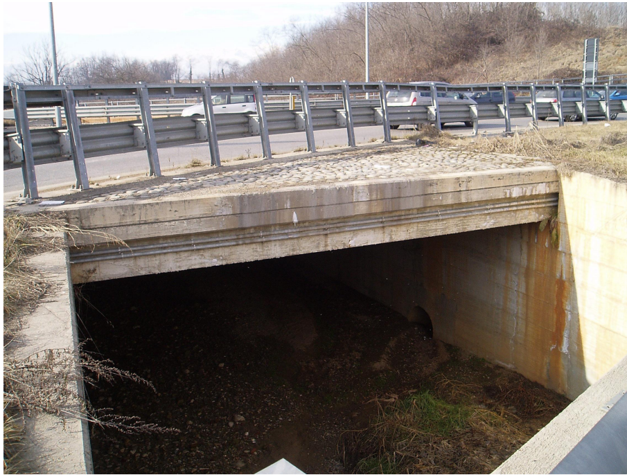
Figura 2-19 – Attraversamento del Garosso di Rivoli in corrispondenza della SP 145, della pista ciclabile e dell'accesso alle camere mortuarie dell'Ospedale San Luigi. Vista da valle, dalla strada di accesso alle camere mortuarie (foto 1213-P2050222).
