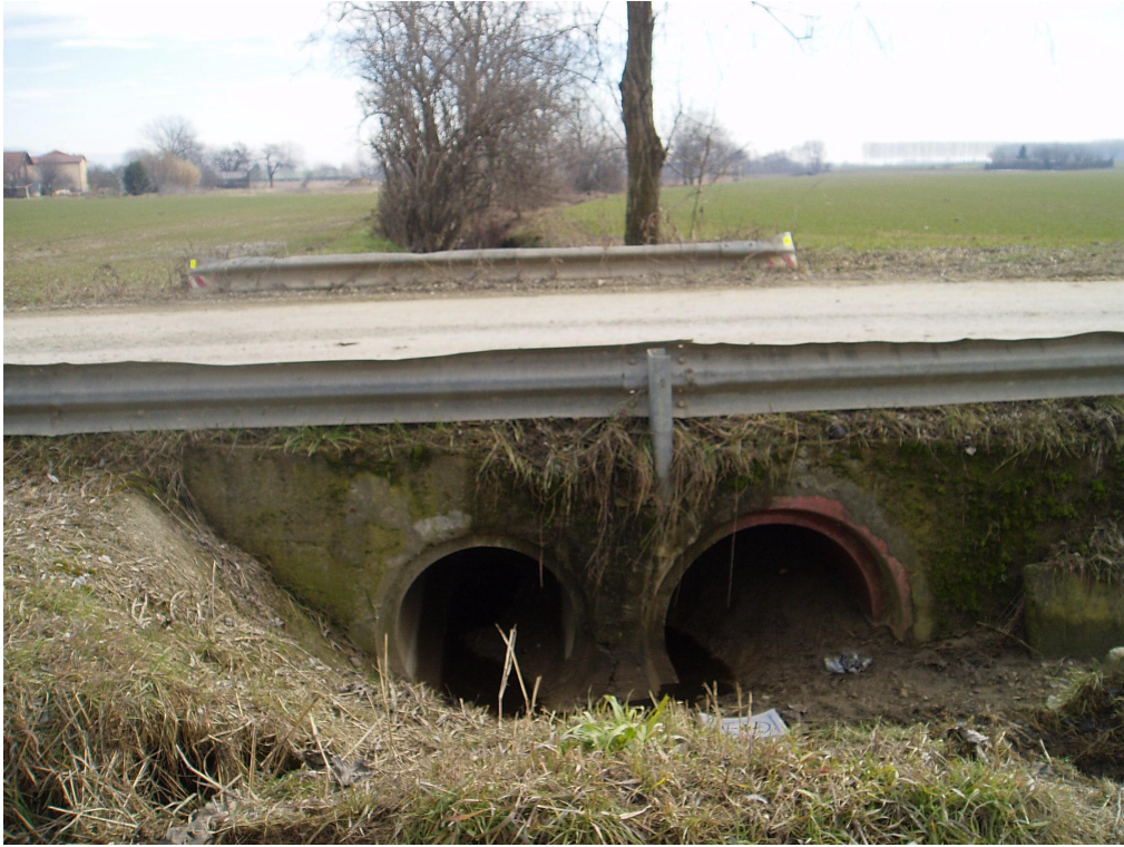
Figura 2-3 – I due condotti che alimentano, alla testata, il Garosso di Tetti Neirotti. Sullo sfondo, a sinistra, la periferia di Tetti Giachetto (foto 1316-P2050181)
