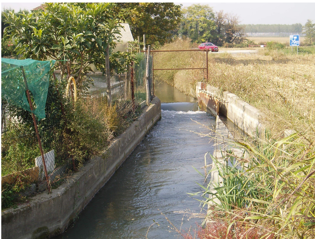
Figura 2-17 – Partitore da cui si origina la Bealera della Cascina Gonzole dal Canale Comunale di Orbassano presso il Dojrone (vista verso monte; foto 923-PA10024)
