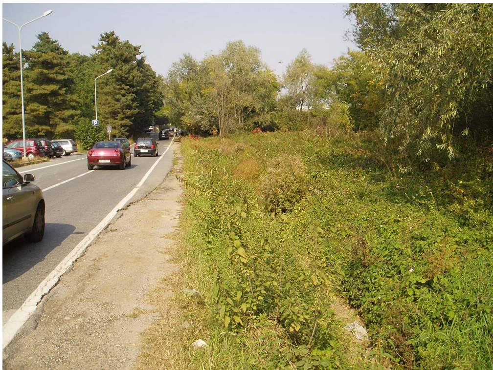
Figura 2-15 – Il fosso in fregio alla strada di accesso all'Ospedale San Luigi in cui scorrono le acque provenienti dalla Bealera San Luigi, quelle della Bealera di Cascina Gonzole proveniente da destra della foto e le acque piovane in esubero che si raccolgono sulle superfici impermeabili (strade e parcheggi, anche se dotati di rete di smaltimento) (foto 923-PA100027)
