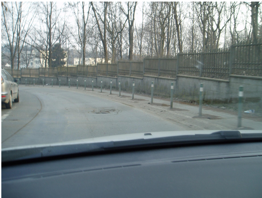
Figura 2-16 – Strada di servizio fra i parcheggi dell'ospedale con rete di raccolta delle acque con normali pozzetti al centro con griglia sicuramente insufficienti alla raccolta delle acque in caso di forti intensità, anche data la forte pendenza della strada (foto 1212-P1270098).
