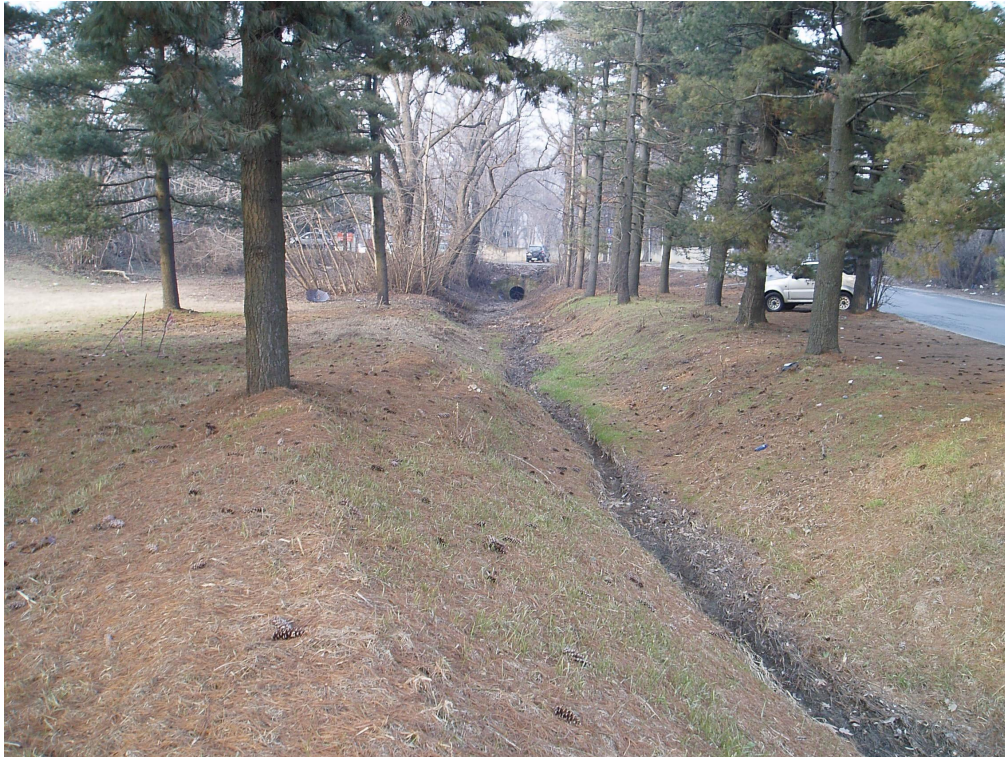
Figura 2-12 - Bealera San Luigi all'interno dell'Ospedale San Luigi all'attraversamento della strada di servizio per le ambulanze con manufatto già ritenuto insufficiente (Provincia di Torino, 1998) (foto 1212-P1270099).
