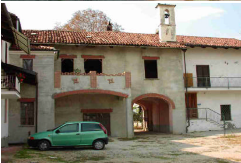
Prospetto interno sud ovest
