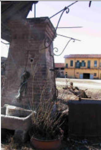
Particolare lavatoio in pietra e orditura tetto metallica
