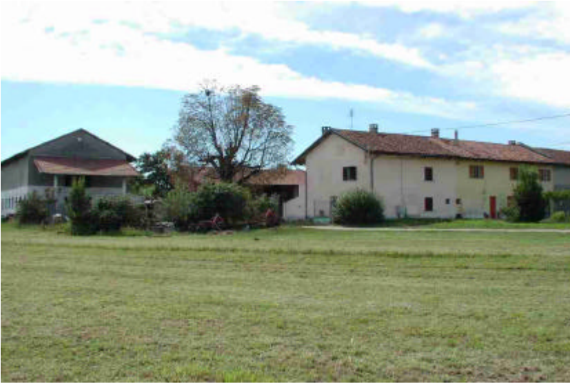
Panoramica lato sud est
