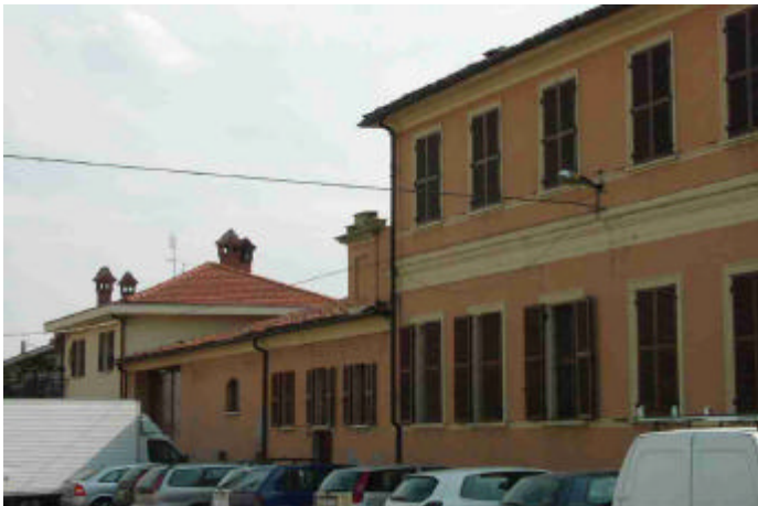
Particolare prospetto nord
