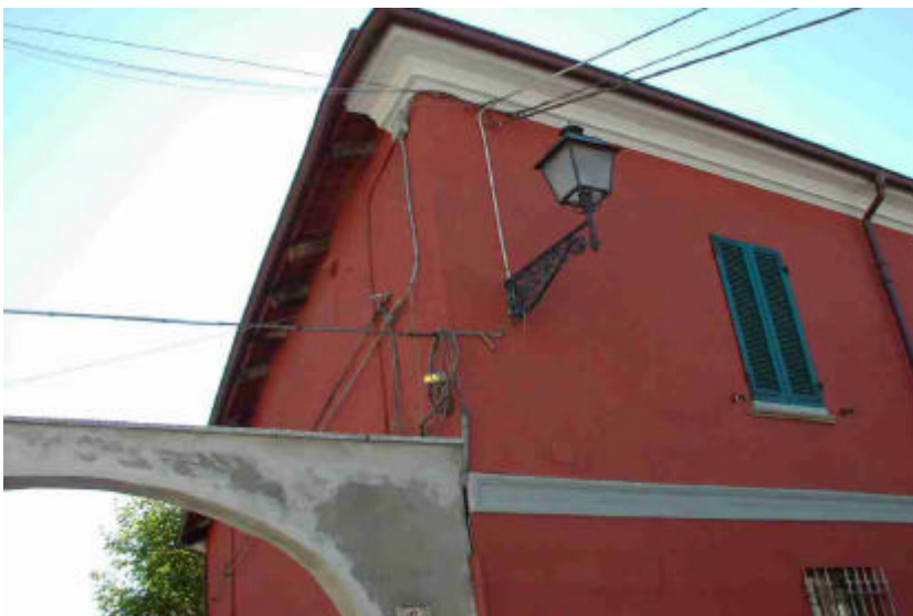
Particolare finestra e tetto
