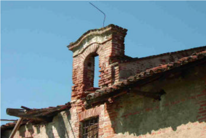
Particolare torretta campanaria
