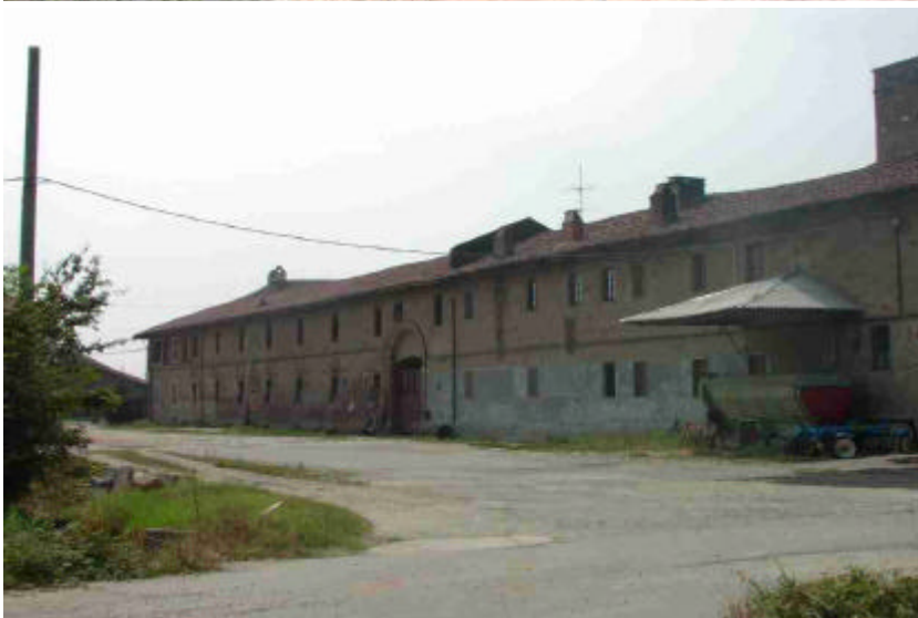
Panoramica prospetto est
