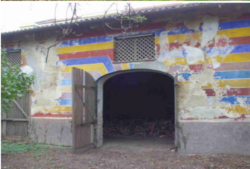
Particolare portone magazzino
