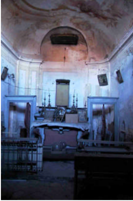
Interno, particolare abside
