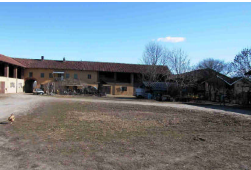
Panoramica cortile verso ingresso carraio
