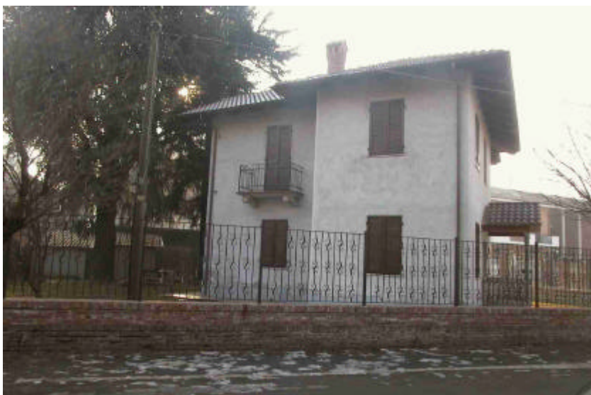
Prospetto laterale dopo l'intervento di recupero (ancora in corso)
