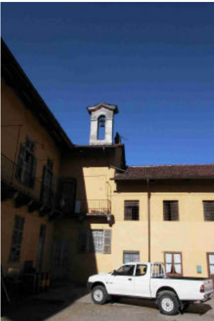
Particolare con torretta campanaria
