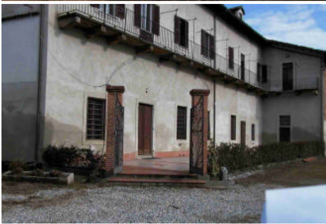
Particolare prospetto sud
