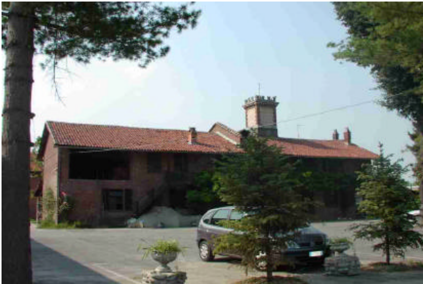
Panoramica prospetto principale
