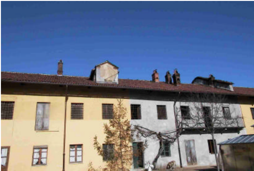
Particolare prospetto lato cortile
