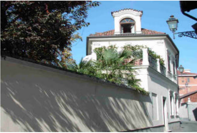
Prospetto laterale con terrazzo
