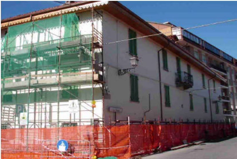
Prospetto lato strada
