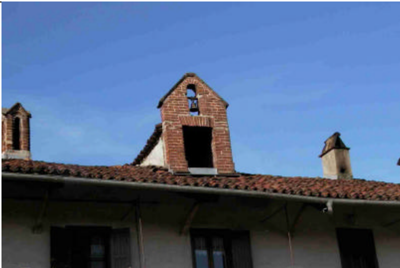
Particolare torretta campanaria
