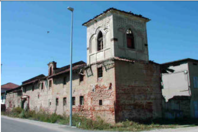
Prospetto sud e torretta
