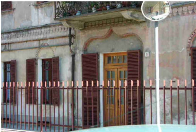
Particolare porta ingresso
