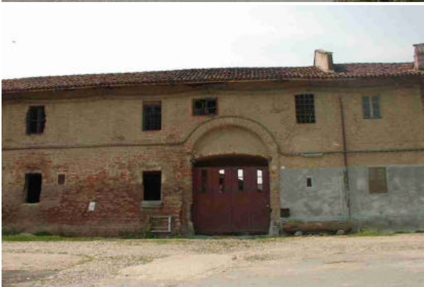
Particolare ingresso carroia
