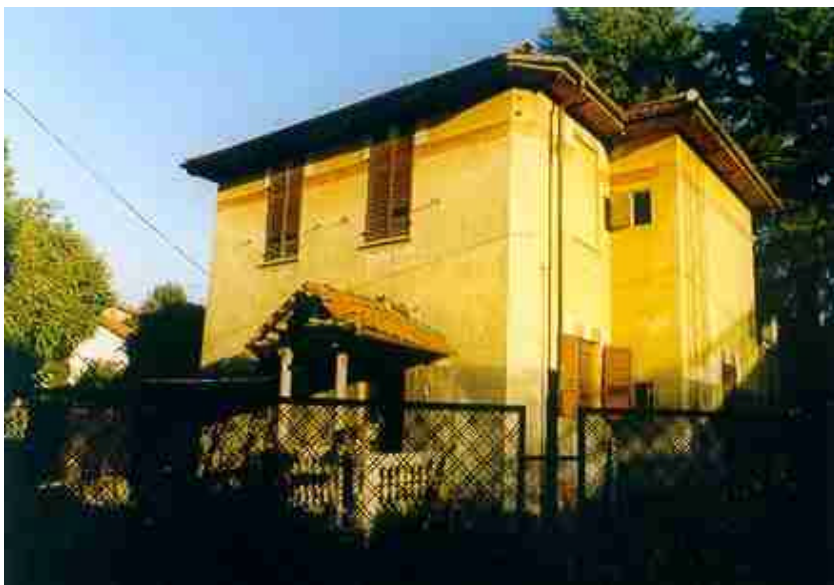
Prospetto principale con decorazioni originali
