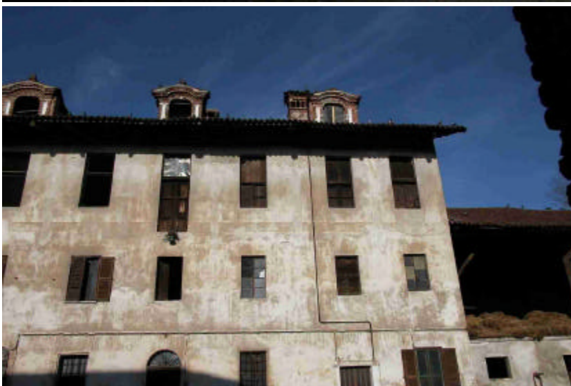
Particolare finestre e abbaini del tetto
