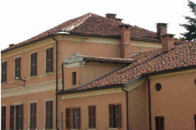
Particolare prospetto nord
