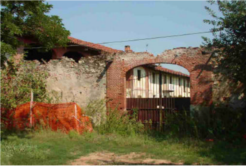
Ingresso e scorcio del prospetto
