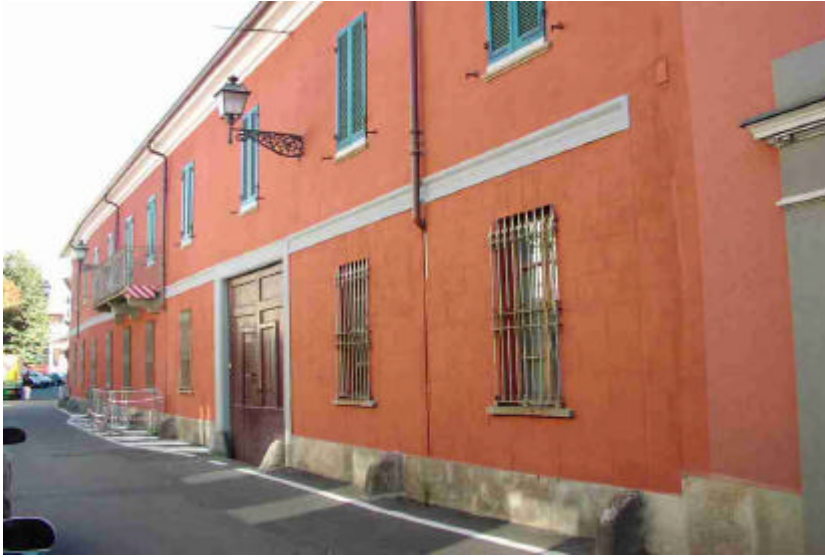
Prospetto principale lato strada
