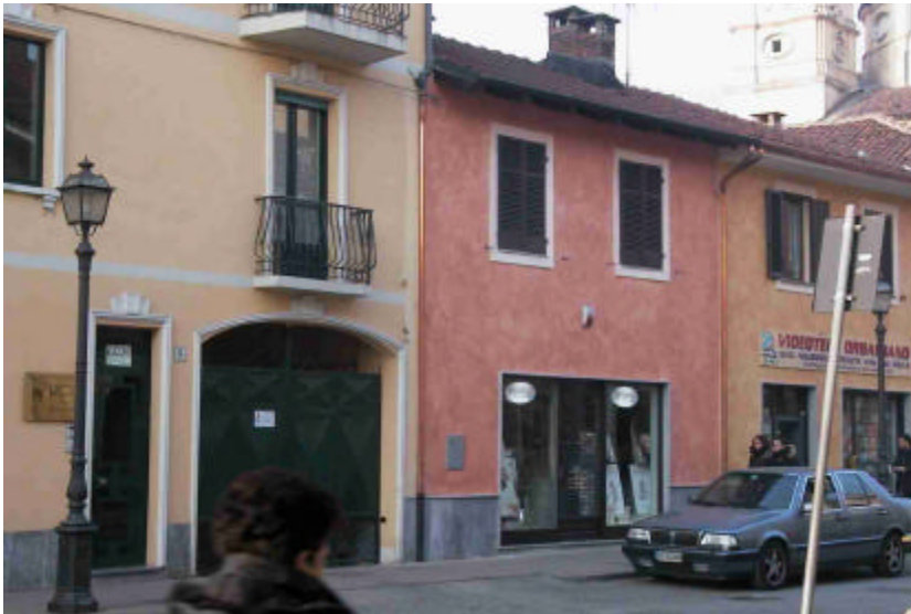
Portone carraio e cornici finestre
