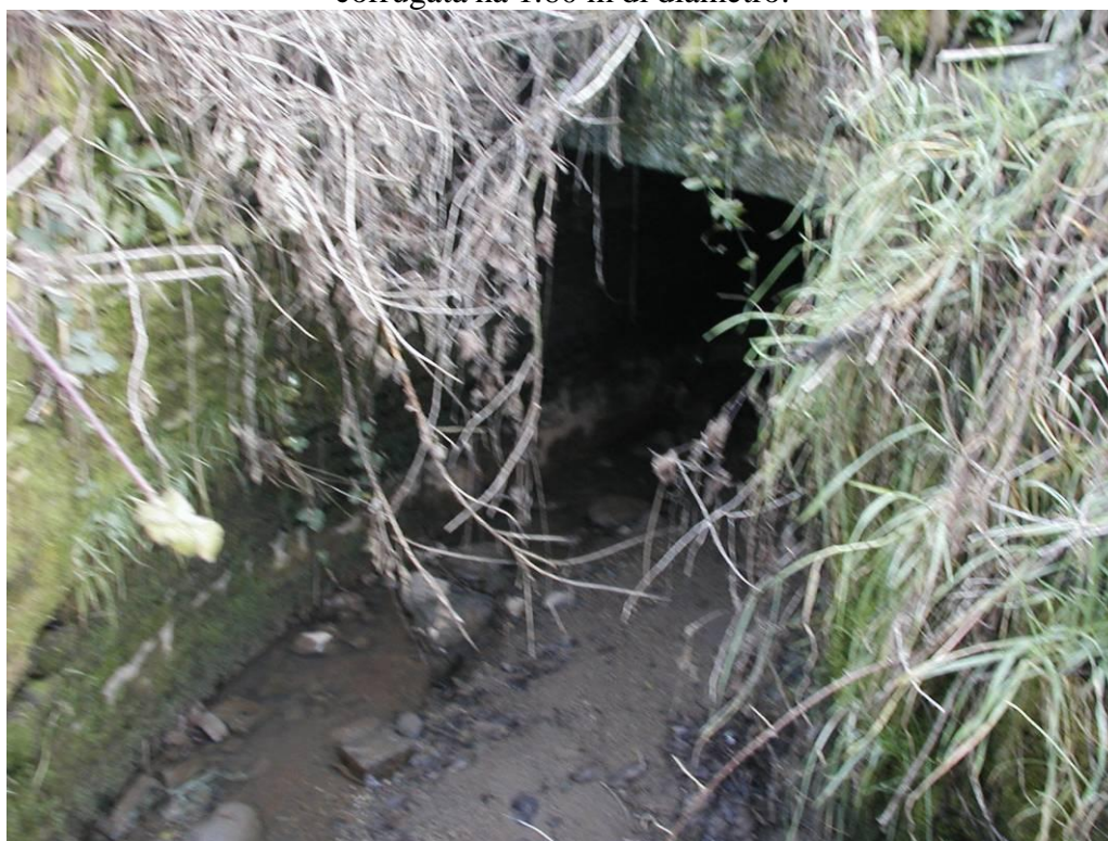
001ANSEAG007 – Imbocco di monte (foto Foto2-PC300022; gennaio 2003)
