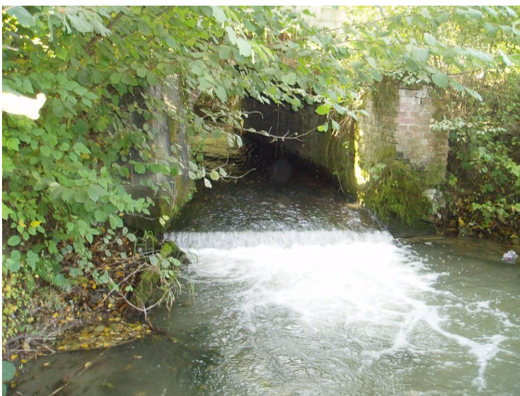
001ANSEAG008 – Situazione a valle (foto 923-PA100041)
