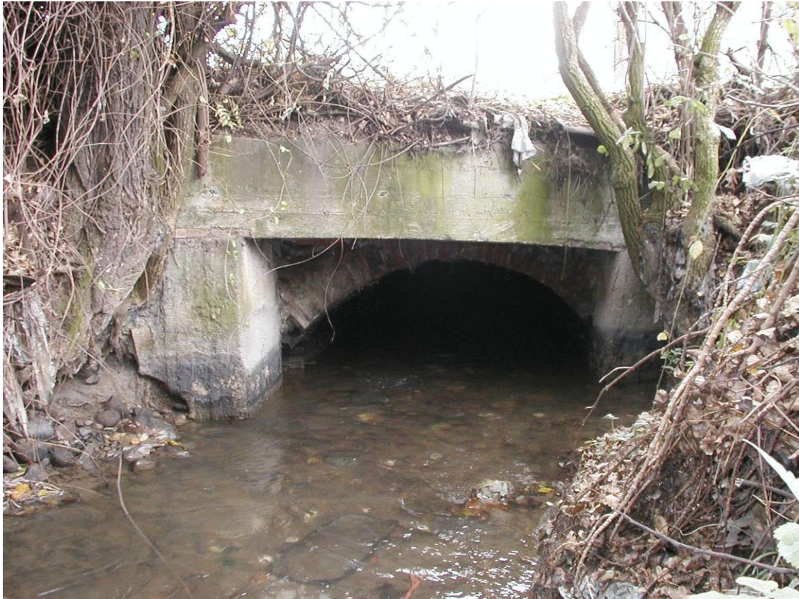
001ANSECA002 – Imbocco a monte con ampliamento su vecchio manufatto ad arco
