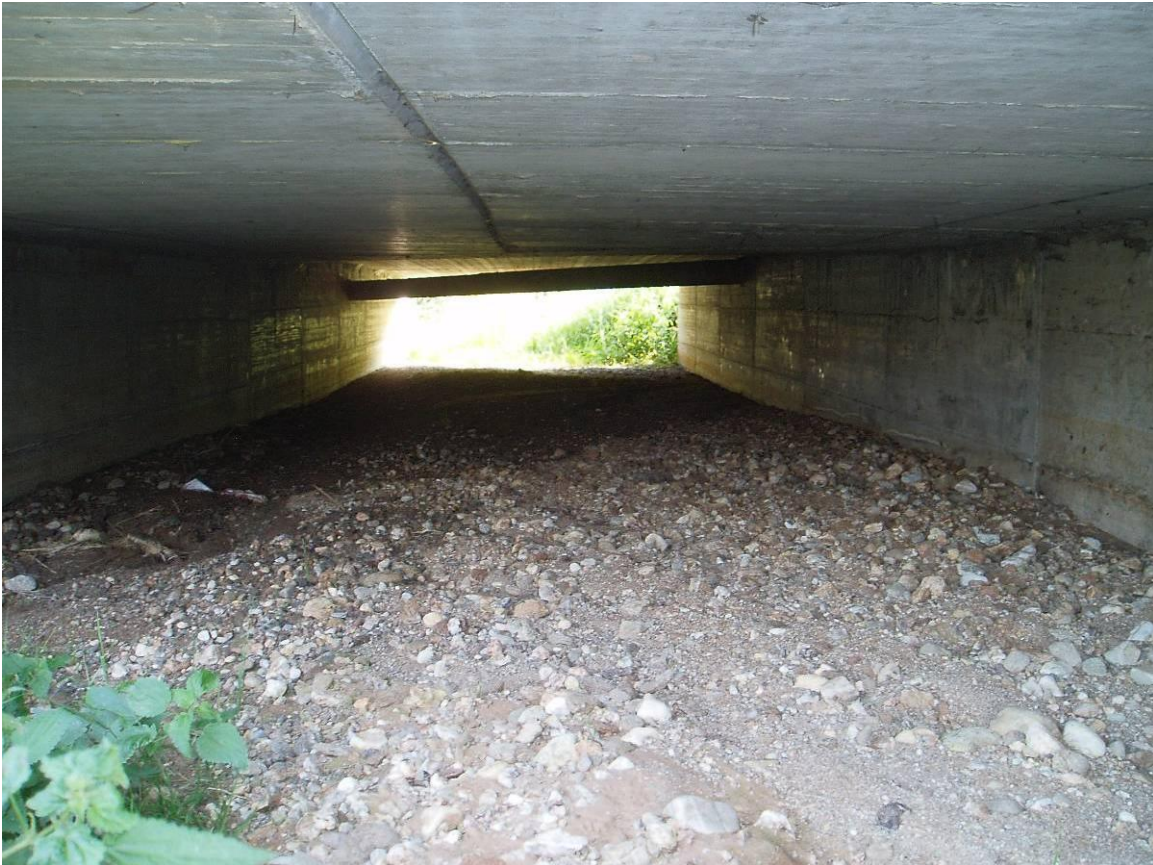
002ANSEPO003 – Vista della luce libera (foto 923-PA100031)
