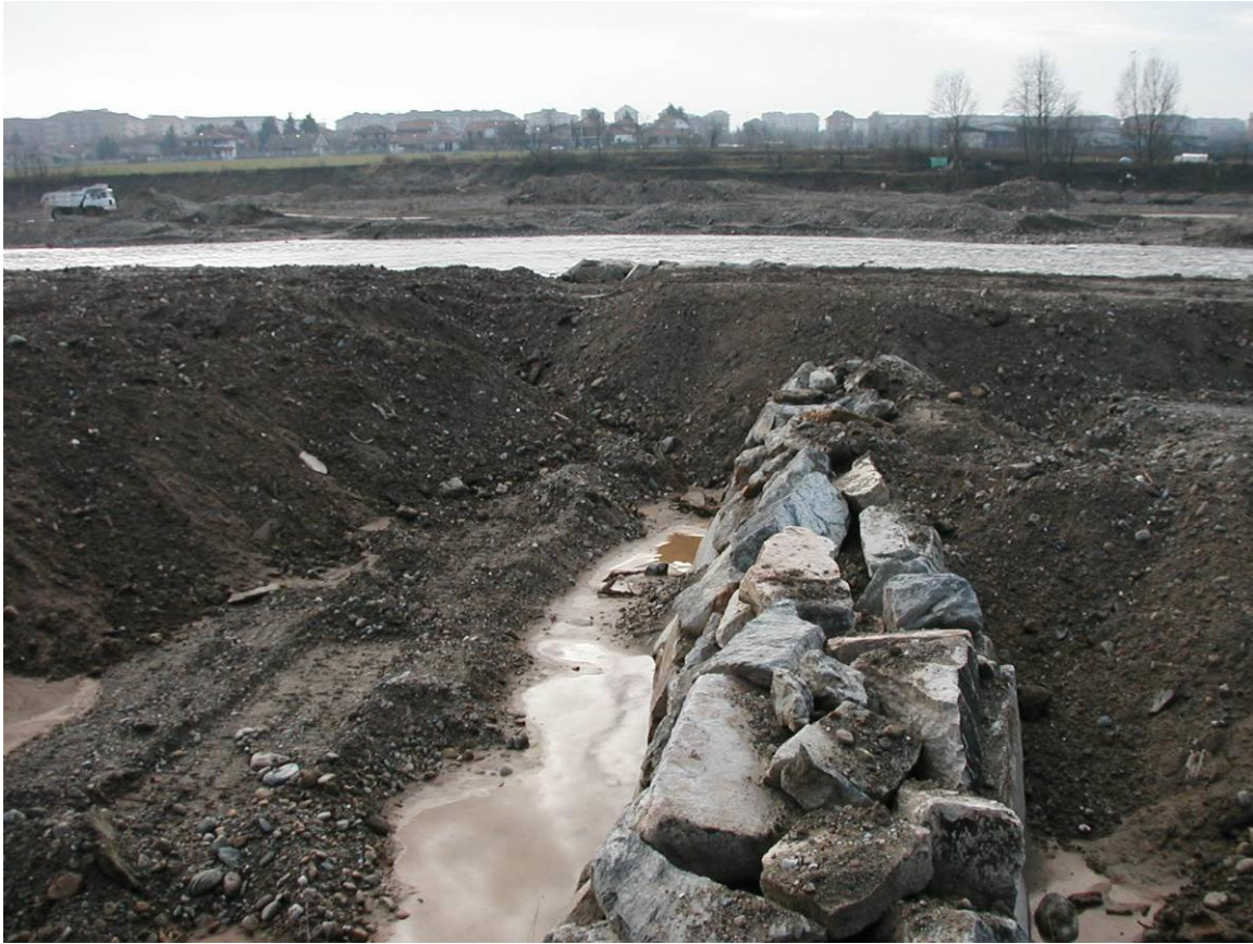
001ANSEPE001 – Vista del pennello dalla sponda durante la sua realizzazione.
