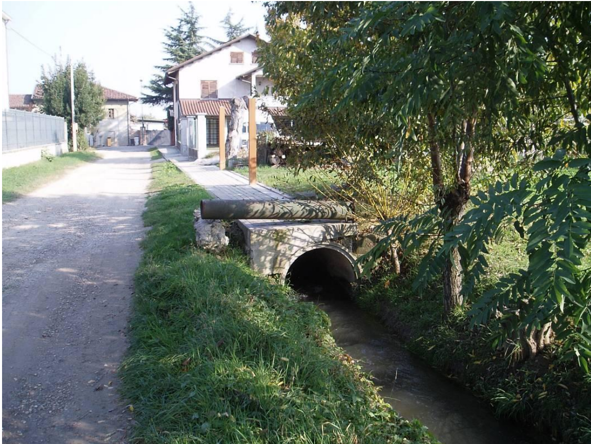
001ANSECA001 – Imbocco a monte di tetti Valfrè (foto 923-PA100042)
