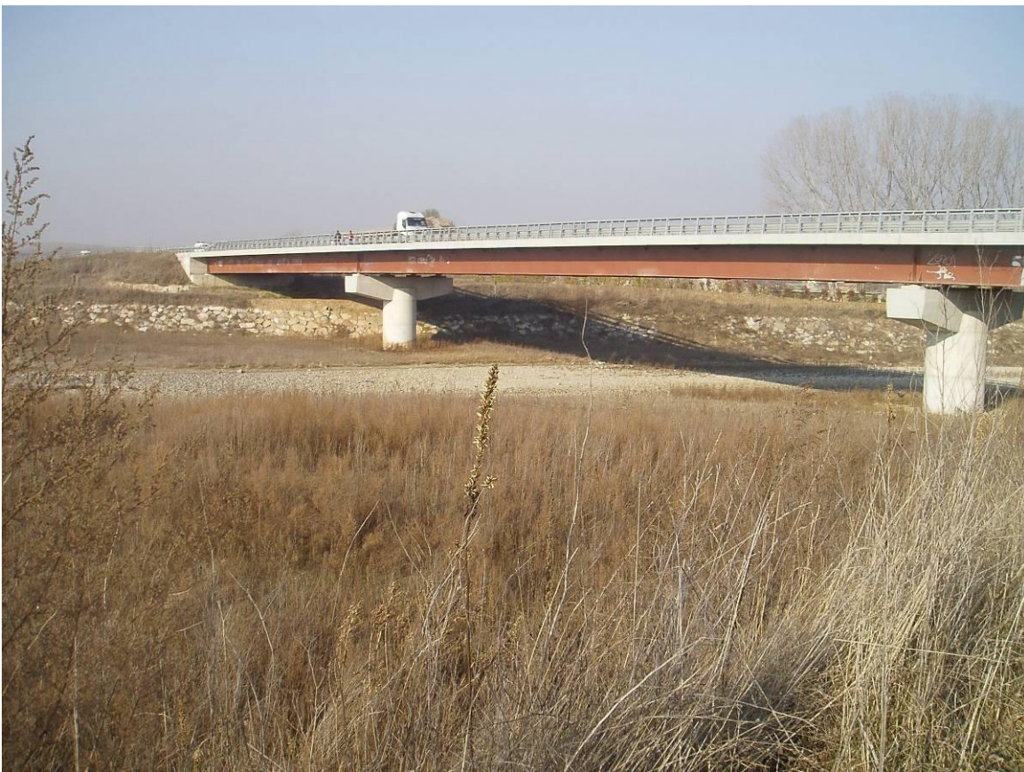
001ANSEPO001 – Vista da monte.
