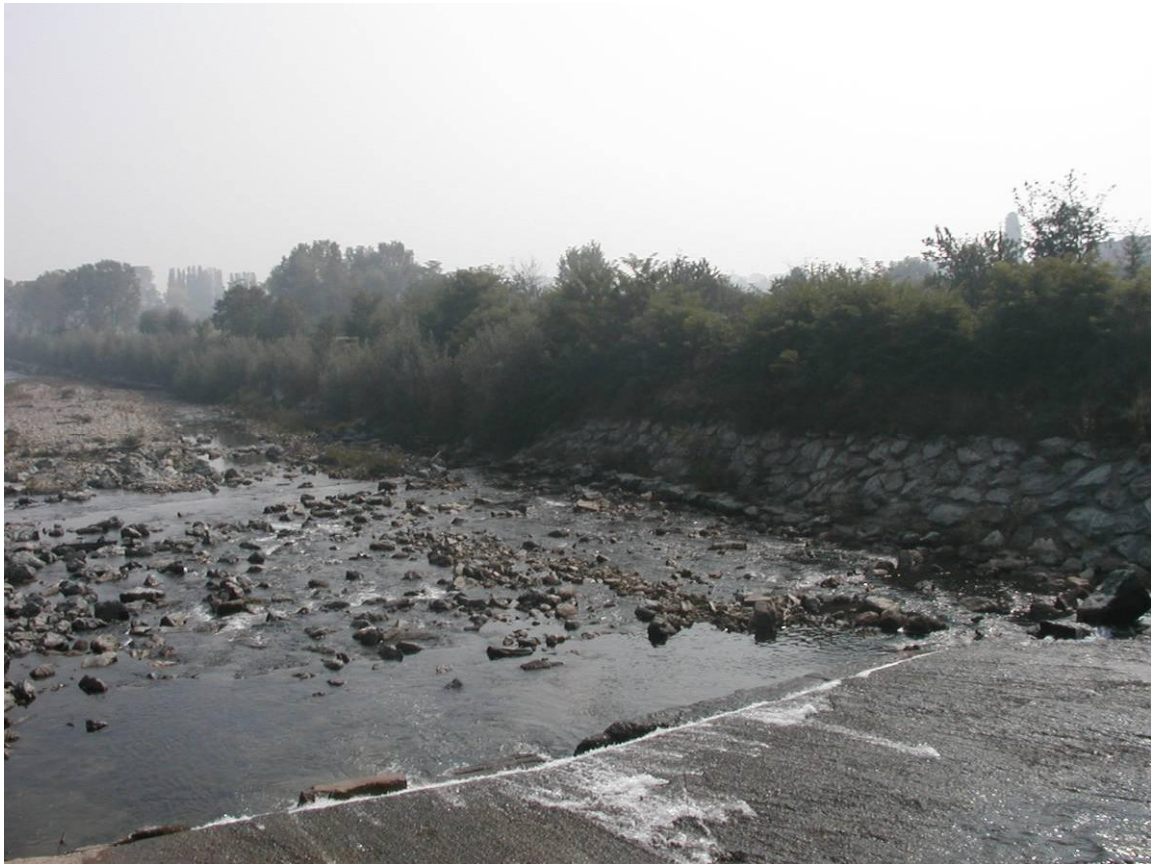
001ANSEDS001 – Scogliera vista da monte nei pressi del ponte della provinciale.
