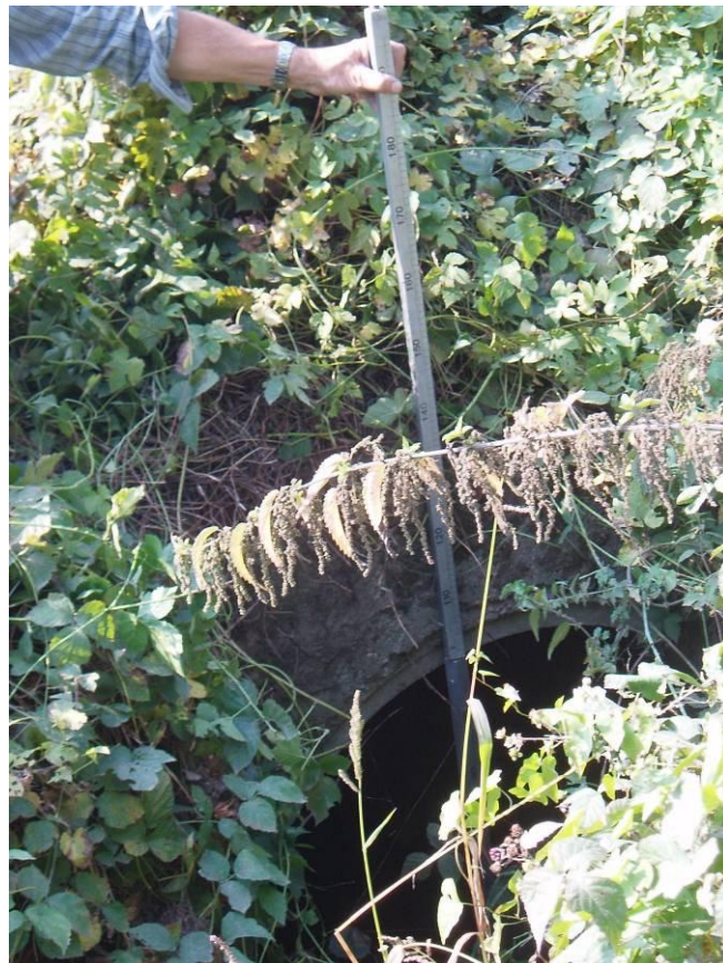
001ANSEAG004 – Vista da monte (foto 923-PA100009) – L'asse è inclinato di 45° rispetto alla strada Rivalta-Beinasco
