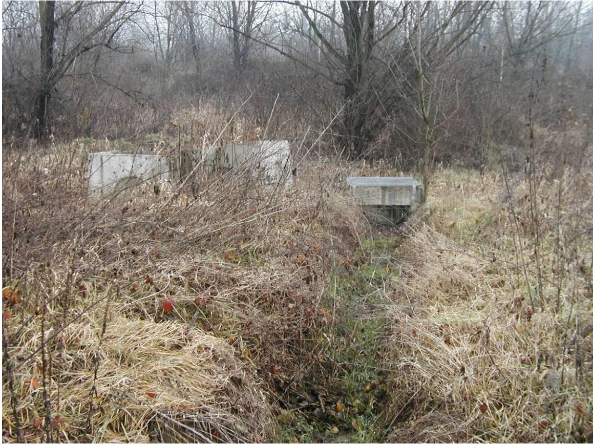
003ANSESCG001 – Dispositivo di scarico (gennaio 2003)
