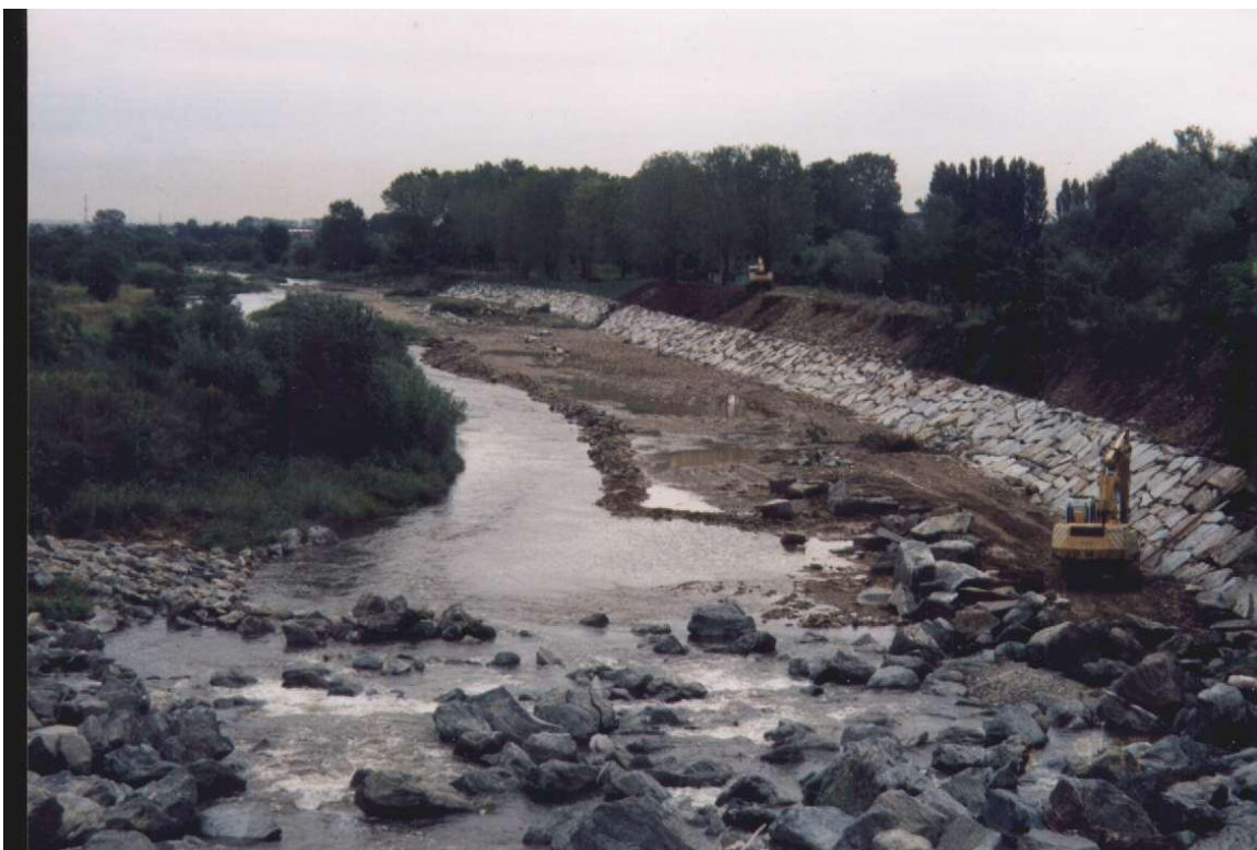
002ANSEDS001 – Vista della scogliera durante la sua realizzazione.
